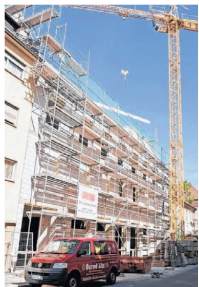
Rohbau fertig: das neue Museumsgebäude in C 4. BILD: PROBWITZ
